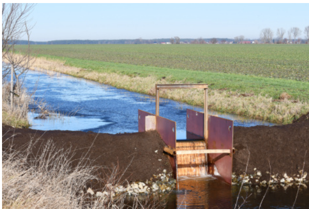
Abbildung 4.8: Fertiggestellter Probestau am Mühlengraben (links) und das Schema zur Beprobung der Erträge und Wasserstände in der Fläche (rechts).
