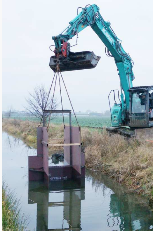
Einbau eines Versuchsstaus durch den Gewässerverband Kleine Elster-Pulsnitz
