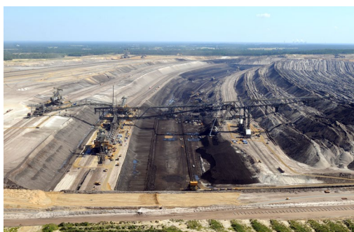
Abbildung 38: Förderbrücke F60 im Tagebau Welzow-Süd (2005), seit 1972 in Betrieb: kontinuierliche Beräumung des Deckgebirges, darunter die Arbeitsebene mit dem freigelegten Flöz.
